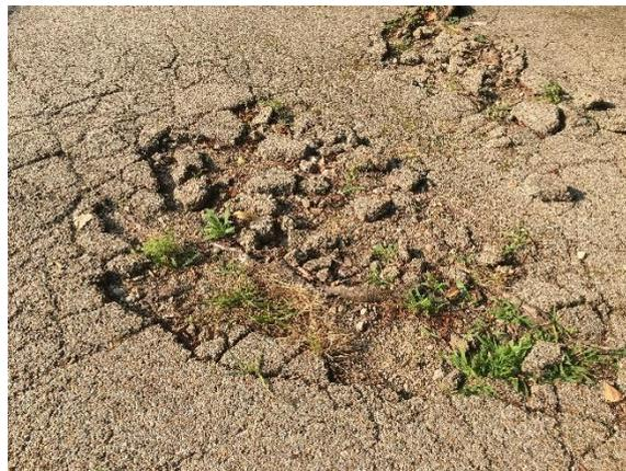
Figura 39 - Pavimento terraway danificado.
