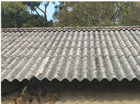
Figura 36 - Telhado em amianto.
